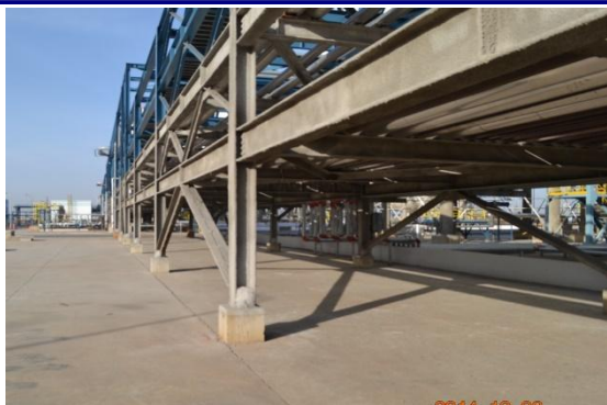
管廊区地面硬化
