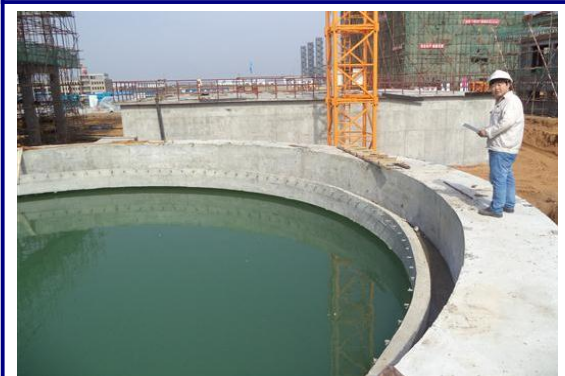
污泥浓缩池满水试验
