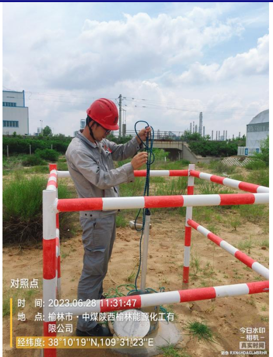
地下水监测井对照点 16#
