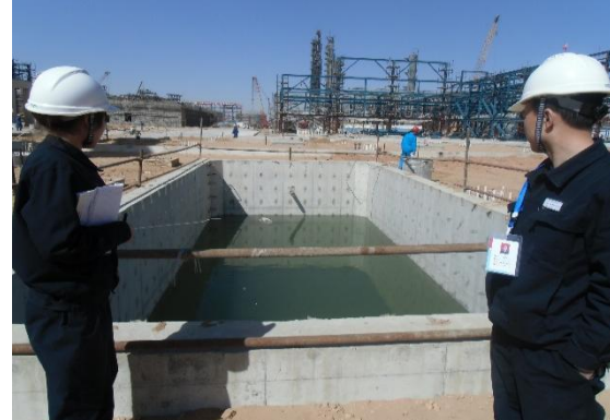
DMTO 污水提升池试水试验
