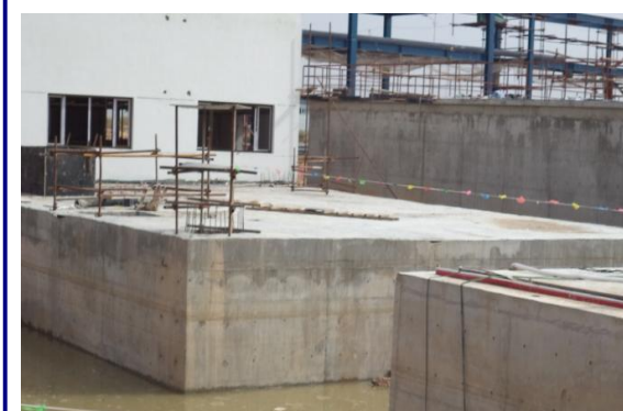
甲醇装置初雨池满水试验
