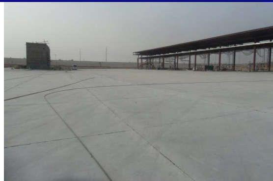
汽车装卸站台场地硬化
